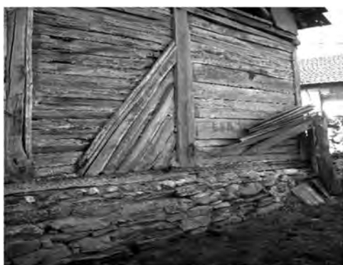
Fig. 24 – Detaliu de îmbinări – casă din Izbuc, nr. 179 49
