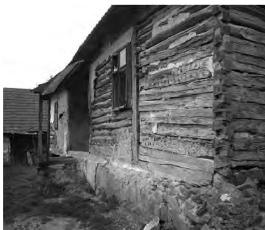
Fig. 42 – Structură de rezistență mixtă, cu stâlpi și bârne îmbinate cu „chiotori” – Seghiște, nr. 11
