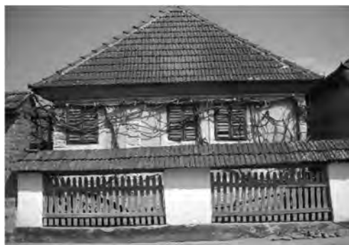
Fig. 52 – Gard din zidărie de piatră tencuită, cu „ochiuri” – Leheceni, nr. 101, Male Sabin
