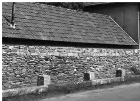
Fig. 51 – Gard din zidărie de piatră de carieră – Criștioru de Jos
