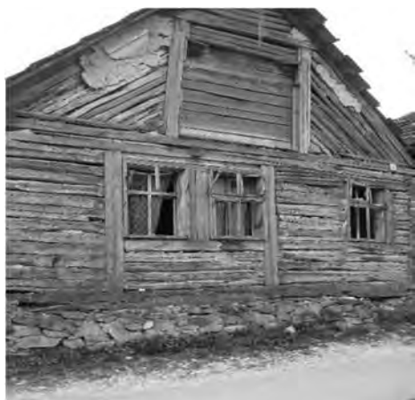
Fig. 42 – Structură de rezistență mixtă, cu stâlpi și bârne îmbinate cu „chiotori” – Seghiște, nr. 11
