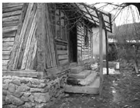
Fig. 37 – Intrare protejată cu copertină – Briheni, nr. 79
