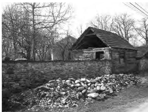
Fig. 50 – Gard din zidărie de piatră de râu – Leheceni, nr. 40
