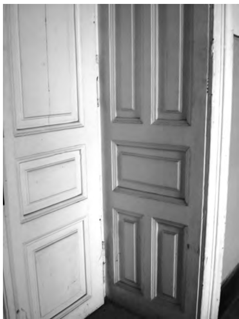
Fig.7. Detaliu de ușă de interior în stil eclectic, reprezentând lemnărie cu profil clasicizant, în casetă, balamale fusiforme turnate, profilate, cu biluțe
